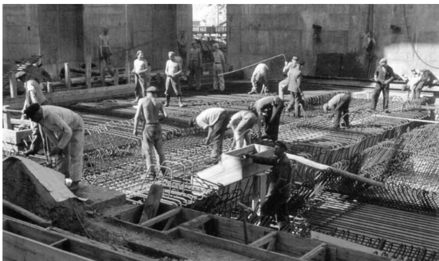
Des déportés de Bremen-Farge, Kommando de Neuengamme, travaillant à la construction du Bunker Valentin, destiné à abriter une chaîne de montage de sous-marins, 1944 (coll. Bundesarchiv, Coblenze)
